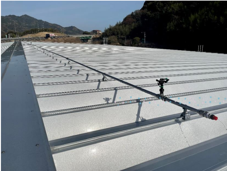
再利用した樹脂製スプリンクラー 427-AGと角度調整用の継手
